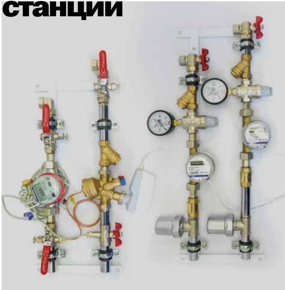
Квартирные станции применяются для присоединения контуров систем водоснабжения и отопления индивидуальных потребителей к централизованному источнику.
